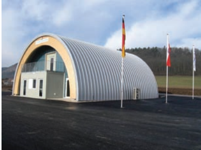
Abb. 14: Informationszentrum an der A 4 am Jagdbergtunnel (DEGES GmbH)
